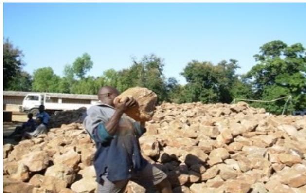
Da una settimana i trasporti hanno garantito che i sia ormai tanto materiale a disposizione. I sassi che sono una delle ricchezze della zona di Mpiri sono già una collina se non proprio una montagna. Serviranno alle fondamenta di tutte le quattro aule (due aule ogni blocco) e tutta la pavimentazione che sarà indistruttibile e inattaccabile alle termiti.
